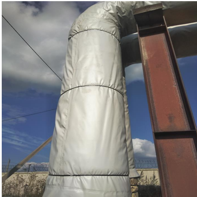
Рис. 5. Гидроизоляция вертикального участка трубопровода
