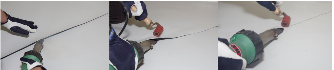
Рис. 2. Ручная сварка методом в «три этапа»
