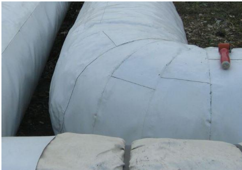
Рис. 7. Смонтированный защитный слой на угловом сегменте
