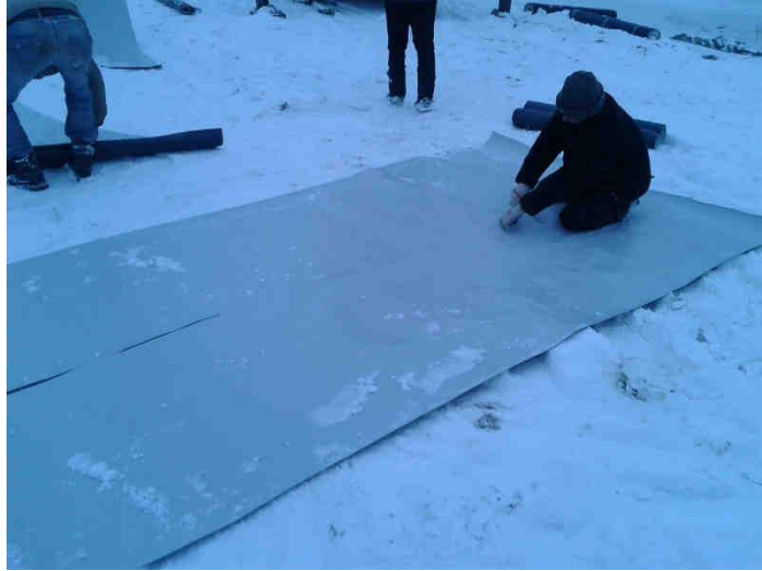
Рис. 4. Процесс изготовления гидроизоляционного ковра
