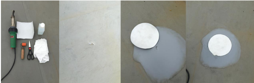
Рис. 16. Ремонт поврежденного участка поверх ПВХ мембраны
