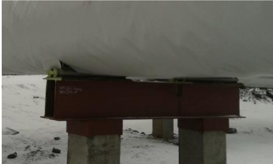
Рис. 10. Примыкание к скользящей опоре трубопровода
